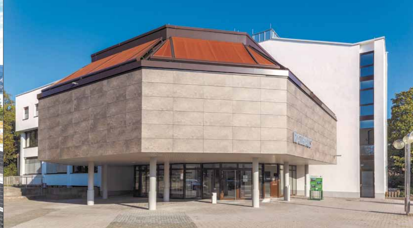
Ein Rathaus in Süddeutschland: Vorteilhafterweise sieht man Keramikfassaden nicht überall, so dass sich alleine daraus schon eine gewisse Individualität und Exklusivität ergibt – hier am Beispiel eines kleineren Gebäudes, das durch Fassadenkeramik im XXL-Format 120 x 60 cm und ein dezent belebtes Design angenehme Präsenz verströmt, ohne sich aufzudrängen. (Foto: agrob-buchtal.de / Herbert Bürger)
