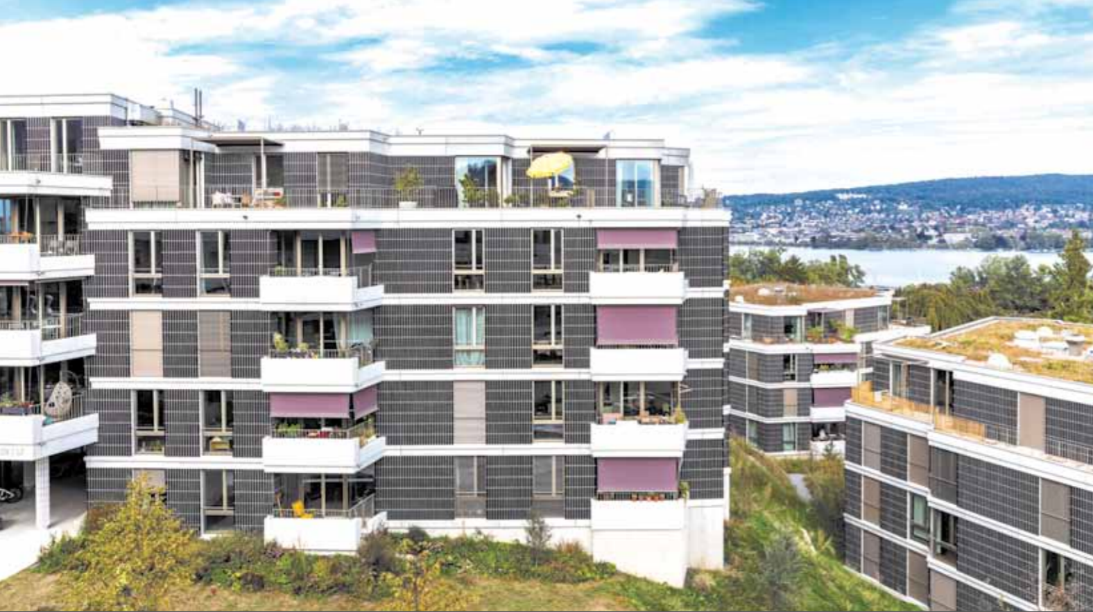
Diese Apartments "Bellaria" in Wollishofen / Schweiz ermöglichen in naturbelassener Umgebung exklusives Wohnen mit Blick auf den Zürichsee. Die Fassade besteht aus dreidimensionalen tiefblau glasierten Keramikfliesen, die je nach Sonnenstand und Tageszeit zu unterschiedlichen reizvollen Effekten führen. (Foto: agrob-buchtal.de / Adriano Faragulo)
