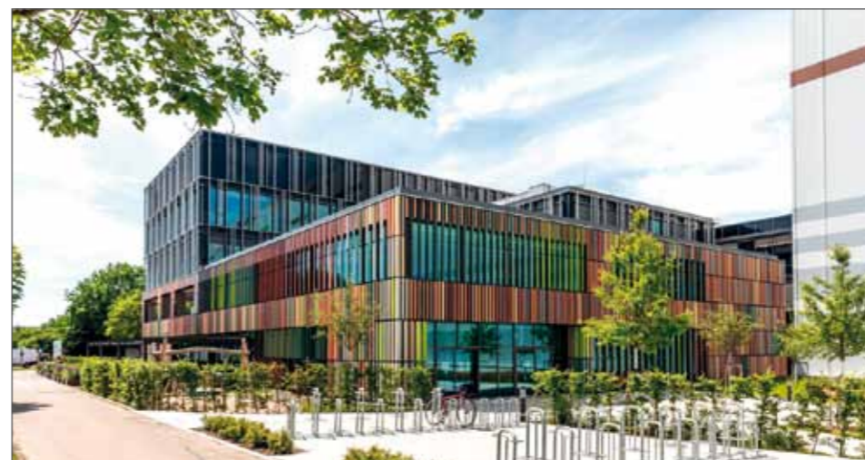
Aufbau und Farbtöne der keramischen Baguettes signalisieren Offenheit, Lebendigkeit und einladende Wirkung zur Seeberger Genusswelt. Der Anspruch, Natur und Nachhaltigkeit in die neue Genusswelt einzubinden, wird mit Keramikelementen aus natürlichem Werkstoff Ton und dem seidenmatten Finish entsprochen.
