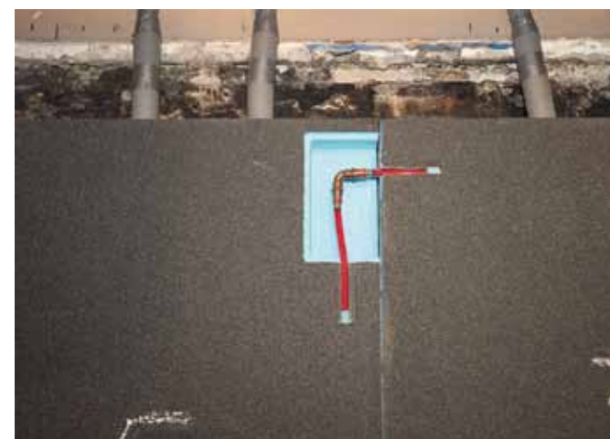
Die Arbeitsschritte im Neptunbad waren optimal aufeinander abgestimmt. Die Wandelemente wurden mit der werkseitig integrierten Verrohrung auf die Baustelle geliefert, beim Aufstellen wurden die Wände untereinander verklebt und die Rohre vom Installateur zusammengepresst.
