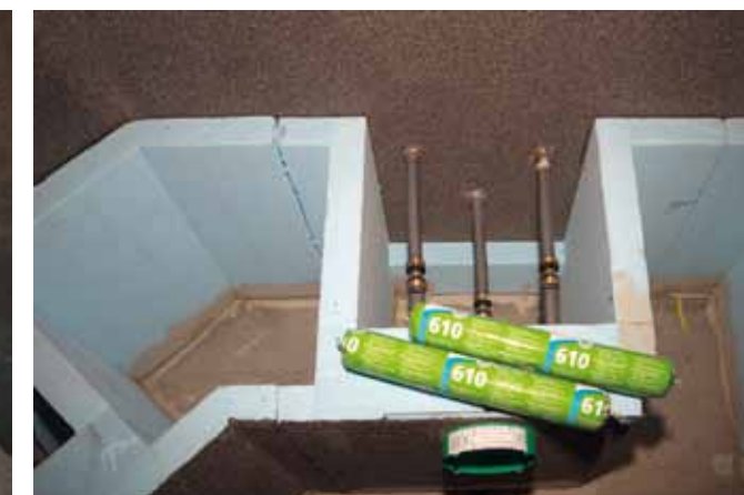
Für die Unterbauten der Sitzbänke wurden die I-Boxen sowie die Anschlussrohre bereits werkseitig eingebaut und eingedichtet. Bevor die Sitzfläche auf den Trägerelementen verklebt werden konnten, wurden die Rohrleitungen durch den Installateur verpresst.
