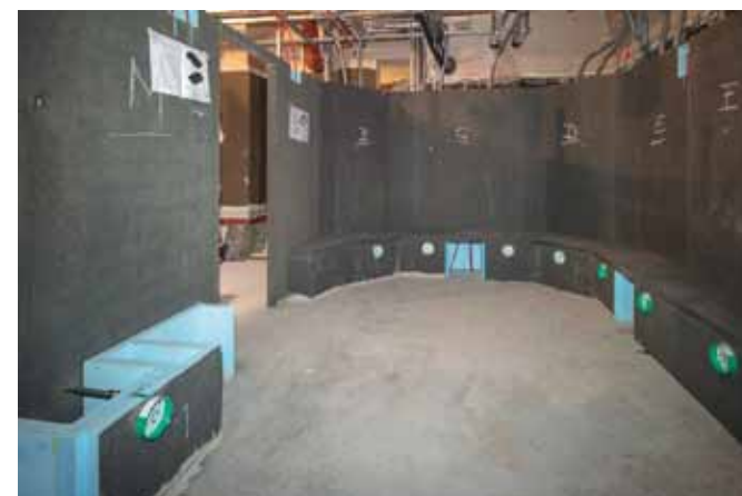
Die Wände in Laconium und Dampfbad des Neptunbads bestehen aus vorgefertigten Wandelementen, die der Verarbeiter nur aufstellen und miteinander verkleben musste. Auch die Sitzbänke wurden werkseitig vorgefertigt.
