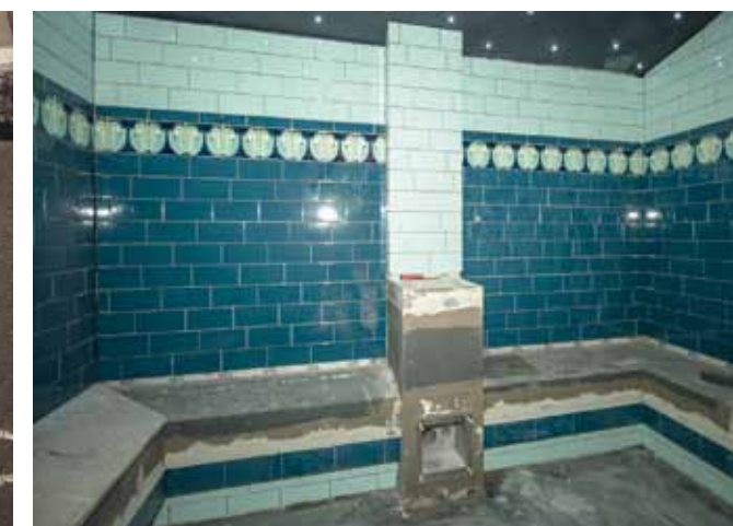
Die Arbeitsschritte im Neptunbad waren optimal aufeinander abgestimmt. Die Wandelemente wurden mit der werkseitig integrierten Verrohrung auf die Baustelle geliefert, beim Aufstellen wurden die Wände untereinander verklebt und die Rohre vom Installateur zusammengepresst.
