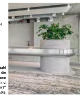
Der Bartresen aus Edelstahl ruht auf zwei Pfeilern, die ebenfalls mit keramischem Rundmosaik der bekleidet sind. Einer von Ihnen „durchbohrt“ gewissermaßen die Platte.
