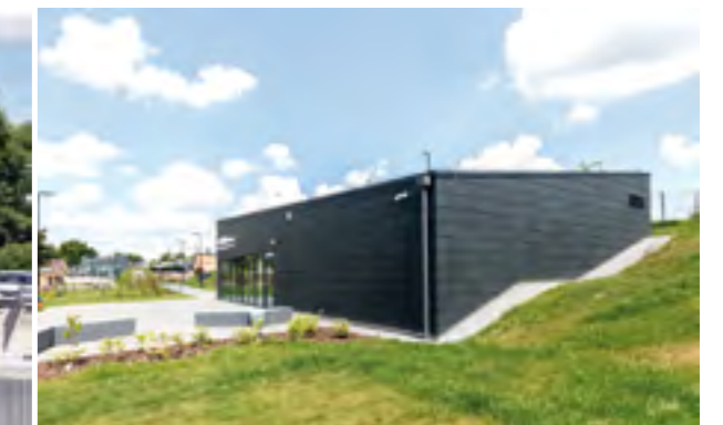
Große Schieferplatten prägen mit ihren bruchrauen Oberflächen das neue Empfangsgebäude
