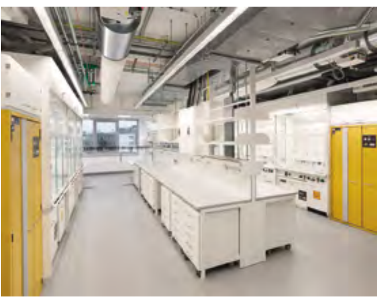
Die fünf Labore für Versuche in partikelfreier Luft sind umgeben von einem Grauraum, der nur über Schleusen für Mensch und Material zugänglich ist.
