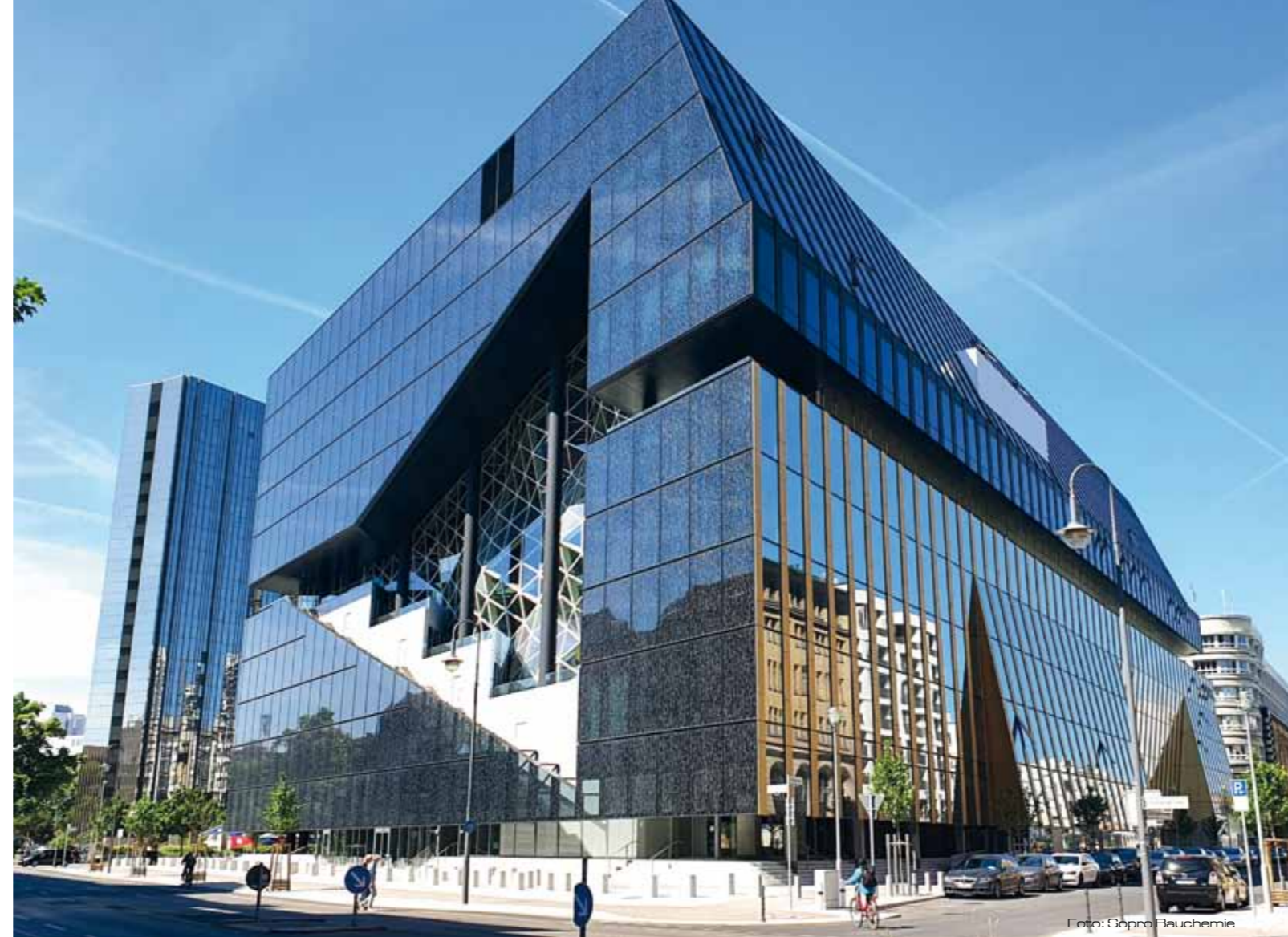
Foto: Sopra Bauchemie
