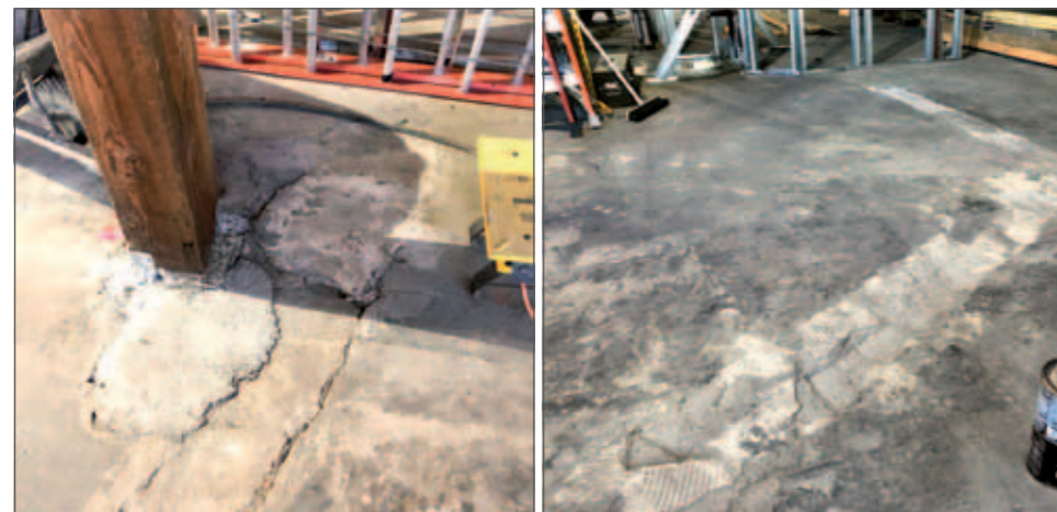
Die Ausgangslage war alles andere als vielversprechend: Risse, Furchen, Abplatzungen, Höhenunterschiede, grobschlächtige Verfüllungen und Klebereste
