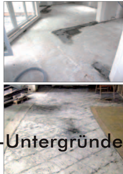
Auf solchen Untergründen neue und schadensfreie Beläge zu erstellen, ist Problem gehaftet. Die bauchemische Industrie hat mittlerweile Systeme entwickelt, die auch in solchen Fällen sichere Lösungen ermöglichen.
