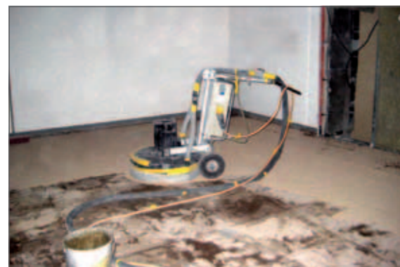
Die richtige und gründliche Untergrundvorbereitung ist für das Gelingen jeder Sanierung unabdingbar.
