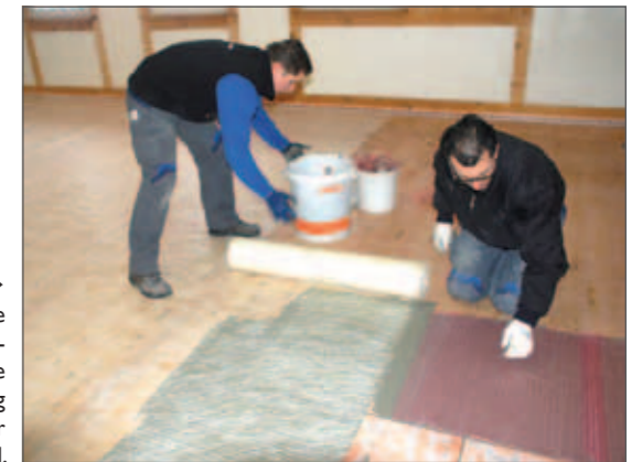
Bei Materialübergängen oder Rissen über drei Millimeter sind als Verstärkung spezielle Glasfaserstränge (in diesem Fall: PCI Armiermatte GFS) vorab in die Ausgleichsmasse einzulegen.
