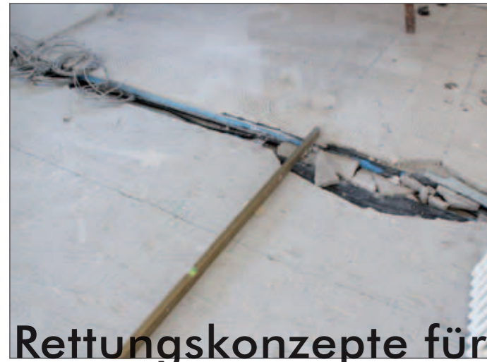
Auf solchen Untergründen neue und schadensfreie Beläge zu erstellen, ist Problem gehaftet. Die bauchemische Industrie hat mittlerweile Systeme entwickelt, die auch in solchen Fällen sichere Lösungen ermöglichen.
