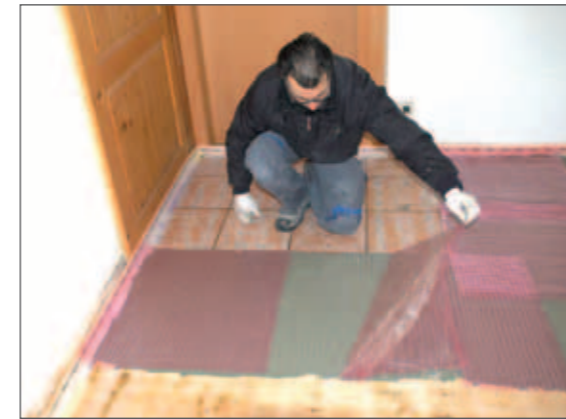
Bei Materialübergängen oder Rissen über drei Millimeter sind als Verstärkung spezielle Glasfaserstränge (in diesem Fall: PCI Armiermatte GFS) vorab in die Ausgleichsmasse einzulegen.
