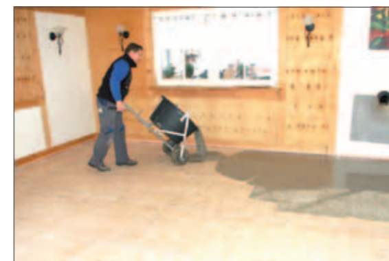
← Als Bodenausgleich wird eine faserverstärkte Spachtelmasse oder eine direkt nutzbare zementäre Ausgleichsmasse auf den so vorbereiteten Untergrund aufgebracht.
