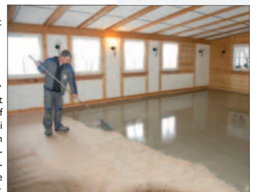
← Als Bodenausgleich wird eine faserverstärkte Spachtelmasse oder eine direkt nutzbare zementäre Ausgleichsmasse auf den so vorbereiteten Untergrund aufgebracht.
