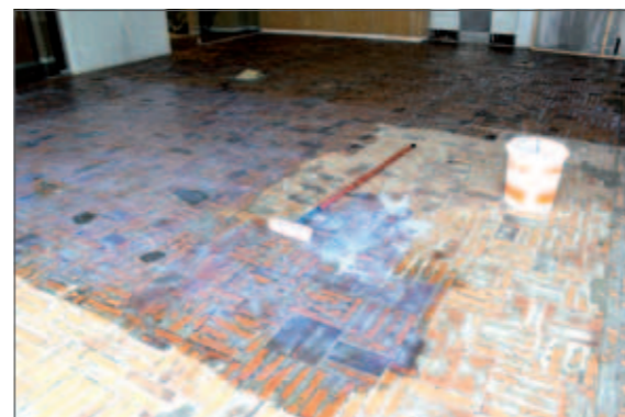
→ Eine Dispersionsgrundierung ist mit der auf den Untergrund abgestimmten Verdünnung der ideale Haftvermittler für den Verbundausgleich.
