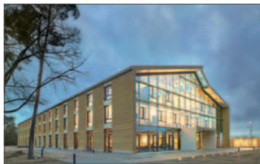
Nominiert für den Deutschen Nachhaltigkeitspreis ist unter anderem dieser Neubau mit einer Stampflehmfassade (Foto: Roland Halbe).
