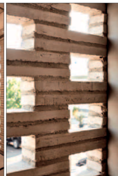
Das Lochmauerwerk fungiert im Treppenbereich als Schutz vor Wind und Regen. Im Laubengang erzeugt es ein lebendiges Spiel aus Licht und Schatten. Wie das funktioniert, zeigt das rechte Detailfoto.
