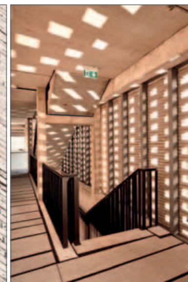
Das Lochmauerwerk fungiert im Treppenbereich als Schutz vor Wind und Regen. Im Laubengang erzeugt es ein lebendiges Spiel aus Licht und Schatten. Wie das funktioniert, zeigt das rechte Detailfoto.
