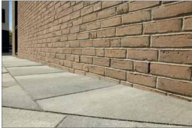
Rundungen mit verschiedenen Radien prägen die Ziegelarchitektur des Forschungszentrums. Ein filigranes Detail des Gebäudes ist die simsartige Trennung von Erd- und Obergeschoss durch eine horizontal verlaufende Vormauerung einer Steinbreite des Fassadenziegels.
