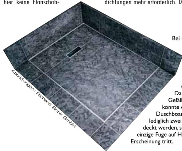
Bei diesem Einbaubeispiel wurden 20 mm starke Natursteinplatten für die Auskleidung des Duschbereichs verwendet. Dank der einfachen Gefälleaufteilung konnte der gesamte Duschboard-Bereich mit lediglich zwei Platten abgedeckt werden, sodass nur eine einzige Fuge auf Höhe des Abflufs in Erscheinung tritt.
