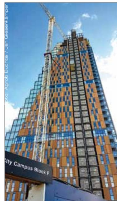
Um die Fassade dezent zu rhythmisieren, wurde die lachsfarbene Keramik in drei differenzierten Nuancen mit ebener oder rillierter Oberfläche projektspezifisch gefertigt.
