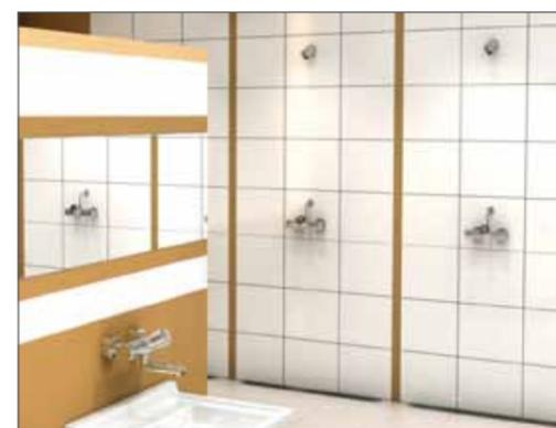
Abbildung 8: Duschen mit einer Nutzungserkennung und darauf abgestimmte Stagnationsspülungen sichern die Gesundheit der Spieler und gehen mit der Ressource Trinkwasser verantwortlich um.
