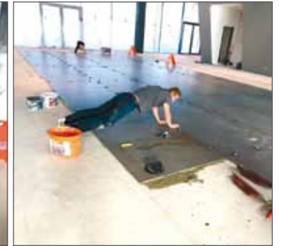
Um die Gesundheit seiner Mitarbeiter zu schonen und eine hochwertige Verlegeleistung zu erzielen, setzte Fliesenlegermeister Hansjürgen Kulmer einen Verlegekran ein. Präzisionsarbeit: Die Großformate wurden exakt eingepasst. Ist eine Korrektur notwendig, lässt sich diese mittels Maschinenteknik einfacher durchführen.
