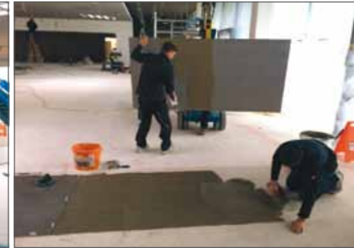
Um die Gesundheit seiner Mitarbeiter zu schonen und eine hochwertige Verlegeleistung zu erzielen, setzte Fliesenlegermeister Hansjürgen Kulmer einen Verlegekran ein. Präzisionsarbeit: Die Großformate wurden exakt eingepasst. Ist eine Korrektur notwendig, lässt sich diese mittels Maschinenteknik einfacher durchführen.
