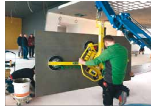
Um die Gesundheit seiner Mitarbeiter zu schonen und eine hochwertige Verlegeleistung zu erzielen, setzte Fliesenlegermeister Hansjürgen Kulmer einen Verlegekran ein. Präzisionsarbeit: Die Großformate wurden exakt eingepasst. Ist eine Korrektur notwendig, lässt sich diese mittels Maschinenteknik einfacher durchführen.
