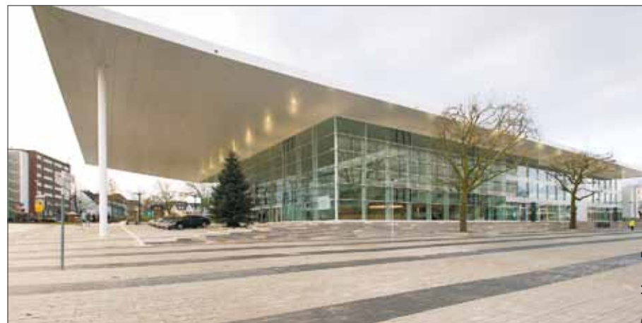
Ein „Schmankerl“ erwartet die Besucher der SHK Essen. Es empfängt sie das neue, repräsentative 2.000 m 2 große Glasfoyers mit direkt anschließenden neuen Kongressräumlichkeiten, das als erster Bauabschnitt der Runderneuerung des Essener Messegeländes im Herbst 2017 eingeweiht wurde
