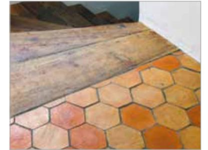
Oben: Diese hexagonalen Fliesen passen zum alten Bohlenholz der Treppe. Sie sind handgewischt und die Farbunterschiede sind entstanden, weil das Rohmaterial aus unterschiedlichen Schichten der Tongrube stammt.
