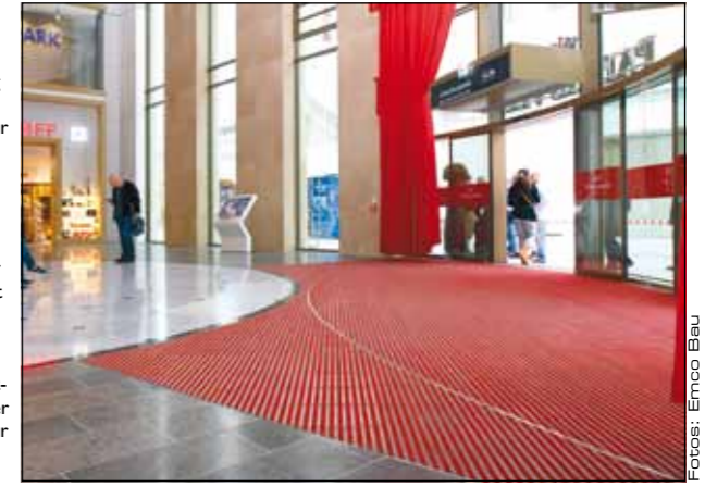
Links: Als bestmögliche Lösung für die vorbeugende Schmutzreduzierung werden Systeme nach dem Prinzip der 3-Zonen-Reinigung empfohlen.
