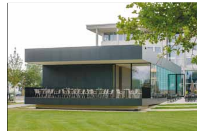
Für das ökoefiziente Gastronomiekonzept „Pavillon Bertrange“ wurden die großformatigen Platten XLight verwendet. Das Format 100 x 300 cm gewährleistet sowohl Dynamik bei der Installation der Fassade als auch ein ansprechendes Design. (Foto: Tile of Spain/ Porcelanosa Grupo)
