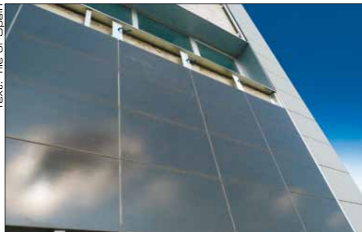
„Cool Tile“ ist eine reflektierende keramische Wandverkleidung, mit der die Energiekosten gesenkt werden können. Es handelt sich um eine „kalte“ Fliese, die trotz ihres dunklen Farbtons in der Lage ist, einen Großteil der Sonneneinstrahlung zu reflektieren. (Fotos: Tile of Spain / Keraben Grupo)
