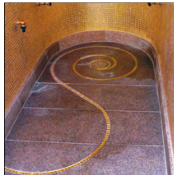
Deutlich zu erkennen sind in dieser Dusche die Verfleckungen im Naturstein durch Staunässe auf der Abdichtungsebene und Kalkablagerungen auf der Belagoberfläche
