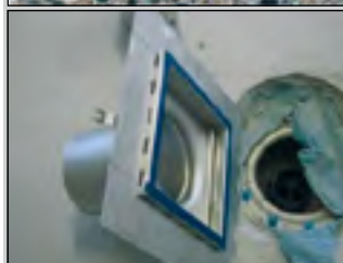
Zeichnung oben: Anschluss Entwässerungsrinne Dallmer CeraLine Plan mit Sickerwasserablauf. Kleines Foto rechts: Bodenablauf für den Großküchenbereich mit Sickerwasserablauföffnungen zur rückstaufreien Entwässerung der Abdichtungsebene
