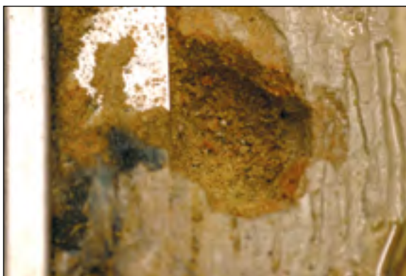
Hoffnungsloser Fall: Zerstörung der Abdichtung und der Rinnevermörtelung durch chemischen Angriff, wie er zum Beispiel in Großküchen erfolgen kann
