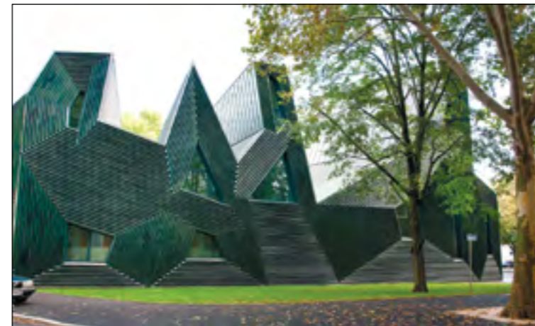
Für den nicht eingeweihten Betrachter erscheint die Fassade der Neuen Synagoge in Mainz wie eine unregelmäßige Grafik, erst dem Insider erschließt sich die tiefere Bedeutung der an Schriftzeichen angelehnten Formen
