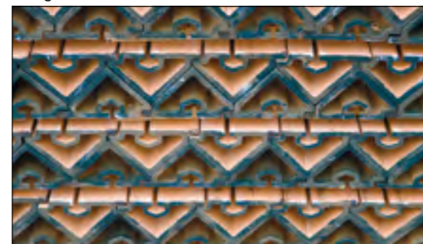
Die Befestigung dreieckigen Keramikelemente auf dem wärmegegedämmten Stahlbeton-Rohbau erfolgte mit Agraffen auf einer Unterkonstruktion aus Aluminium-Profilen
