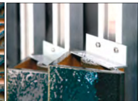
Die Befestigung dreieckigen Keramikelemente auf dem wärmegegedämmten Stahlbeton-Rohbau erfolgte mit Agraffen auf einer Unterkonstruktion aus Aluminium-Profilen
