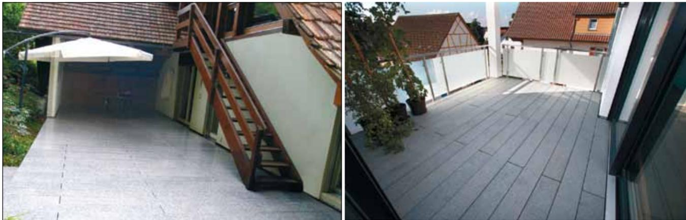
Das „Sasso Naturstein-Schienensystem“ soll eine dauerhafte Lösung für Probleme mit Feuchtigkeit auf Balkonen und Terrassen, die mit Natursteinplatten belegt sind, ermöglichen. Entwickelt wurde es vom Fraunhofer Institut für Produktionstechnik und Automatisierung in Stuttgart und der Firma Schanz Natursteine GmbH aus Rottweil.
