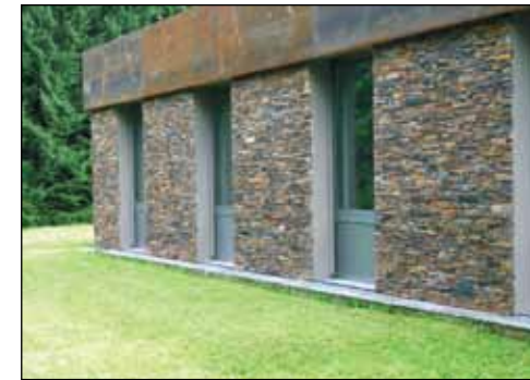
Die Naturstein-Fassadenelemente Stonepanel von Rathscheck Schiefer wurden auf das Verblendmauerwerk geklebt und an den Fenstern plan abgesägt. Ein glatt gefilterter und grau gestrichener Putz vollendet die Laibungen.
