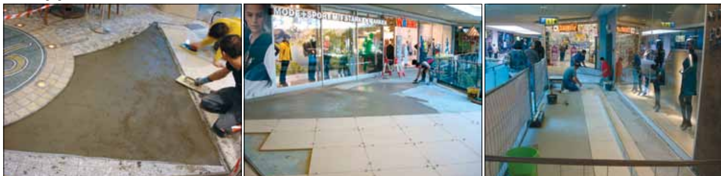
Die Fotos unten zeigen, dass es nicht nur darum ging, große Flächen zu verlegen. Es mussten trotz Zeitdruck zahlreiche Detail-Lösungen realisiert werden, besonders wenn es um die Anschlüsse an die Laden-Einheiten ging
