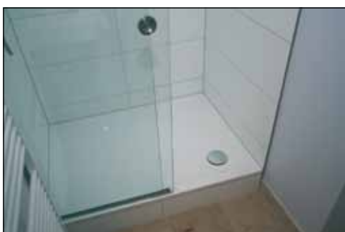
Die emaillierte Duschfläche hat sich in den Bädern des Hotels durchgesetzt. Ihr war auch nach einem Jahr bei einem geringen Reinigungsaufwand die intensive Beanspruchung nicht anzusehen.
