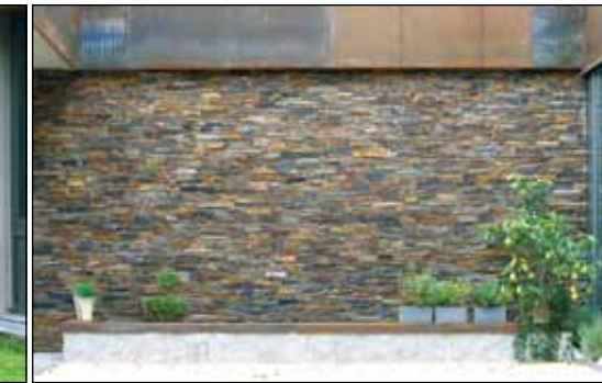
Die Naturstein-Fassadenelemente Stonepanel von Rathscheck Schiefer wurden auf das Verblendmauerwerk geklebt und an den Fenstern plan abgesägt. Ein glatt gefilterter und grau gestrichener Putz vollendet die Laibungen.
