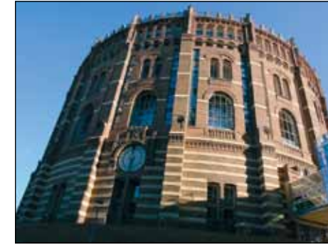
Eine besonders spektakuläre Arbeit Wehdorns war die Revitalisierung einer der vier stillgelegten und denkmalgeschützten Wiener Gasometer. Lediglich Außenmauern und das Dach blieben erhalten. Um die drei anderen Gasometer „kümmerten“ sich die Architekten Jean Nouvel, Coop Himmelb(l)au (Wolf D. Prix), und Wilhelm Holzbauer (1999 bis 2001).
