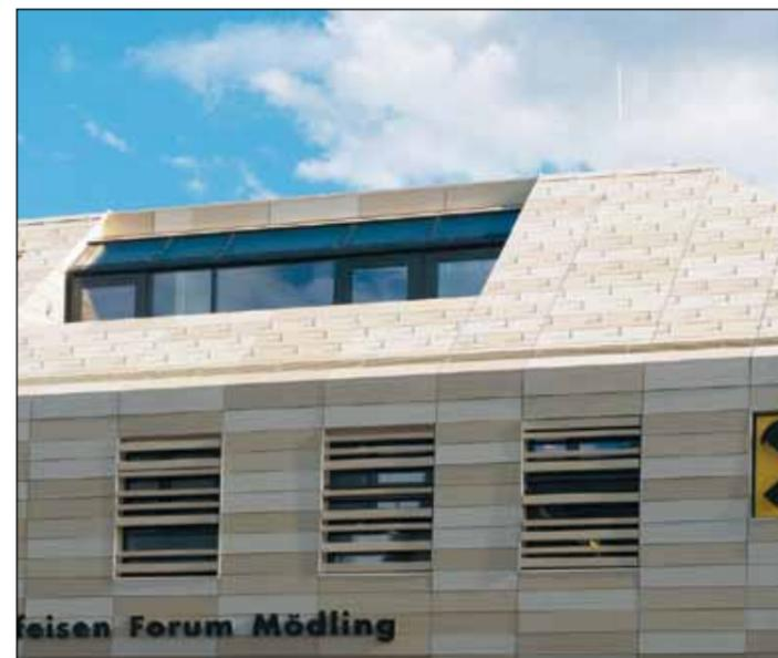
Die abgestuften Sandnuancen der Keramik-Elemente lehnen sich von der Tonalität her an die bestehende Bebauung an. Zur optimalen Umsetzung wurden speziell für dieses Projekt Sonderfarben und -formate gefertigt.
