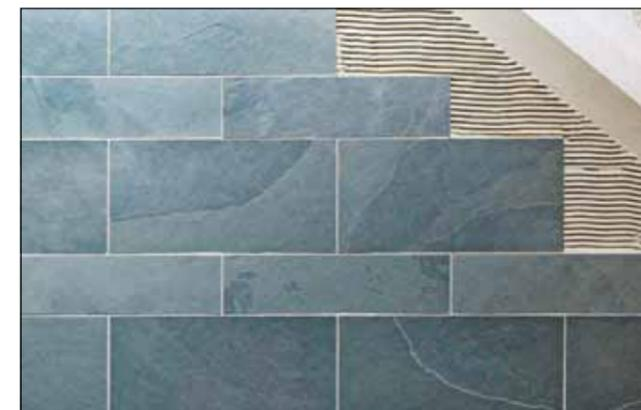
Die bauaufsichtliche Zulassung für das „Lobatherm System mit Natursteinbelag“ beschreibt detailliert den Schichtenaufbau. Besonderheit ist das verstärkte Putzgewebe und das nach DIN 18157/DIN EN 12004 anzuwendende Buttering-Floating-Verfahren, wobei der Klebemörtel auf die Wandfläche sowie die Steinrückseite aufgetragen wird. Abschließend wird die Natursteinfläche mit dem systemeigenen Schlamm-Mörtel verfugt.
