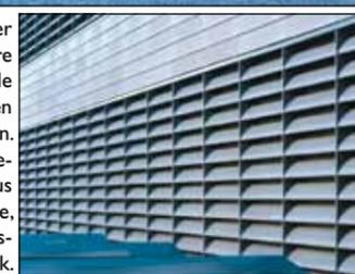
Grauton vorgegeben, der dann speziell für dieses Objekt entwickelt wurde. Diese vorgehängte, wärmegeämmte und hinterlüftete Fassade dient, neben der Optik im Wesentlichen dem zusätzlichen Wärmeschutz.
