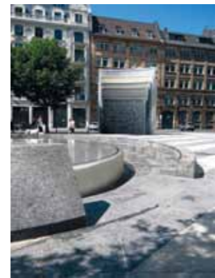
Fachliche Kompetenz bewiesen die Mapei-Anwendungstechniker kürzlich bei der komplizierten Sanierung des Brunns auf dem Frankfurter Jürgen-Ponto-Platz
