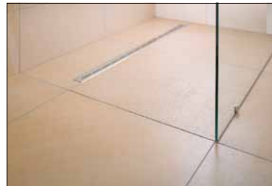
Auch bei der Serie „Sandy“ ist die „Bremswirkung“ gut zu erkennen: In der Dusche rutschhemmende „R10B“-Ausführungen, rundum „R9“-Fliesen (rechts).
