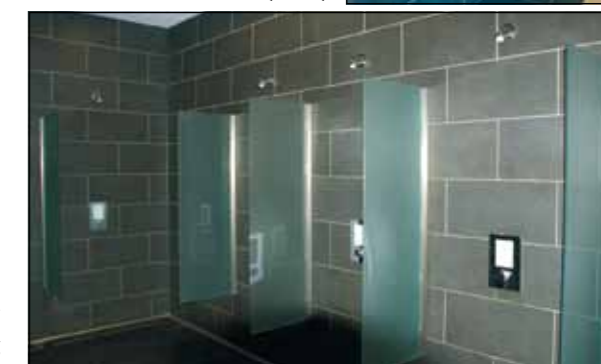
Die Dusch-Armaturen ermöglichen als spezielle Schutzmaßnahme die thermische Desinfektion (unten).
