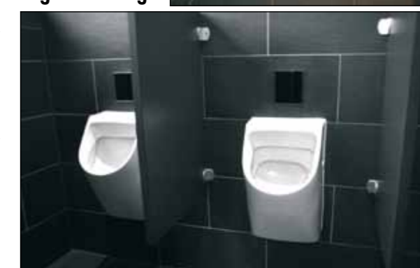
Alle Armaturen funktionieren berührungslos für optimale Hygiene. Besonderer Hingucker sind die bei Annäherung leuchtenden WC-Spülungen
