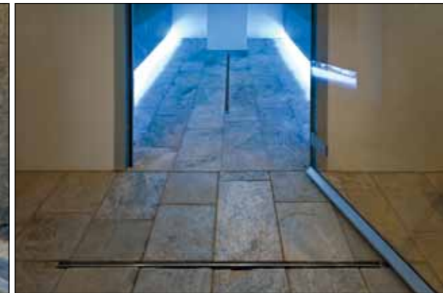
Dezent versteckt sich sogar die Installation im geschichtsträchtigen Ambiente, wofür die schmalen Viega Duschrinnen wie gemacht erscheinen.
