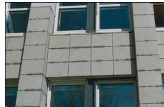
Diese Bilder zeigen Beispiele für die optische Beeinträchtigung der gesamten Fassade durch Randverfärbungen, die nur durch Rückbau zu beseitigen sind.
