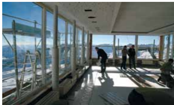
Baustelle mit Ausblick: Wohl eher selten dürften Bauarbeiter eine Baustelle mit einer solchen Perspektive gehabt haben. Hier werden gerade die Umlenkelemente der Rohrträger verlegt.
