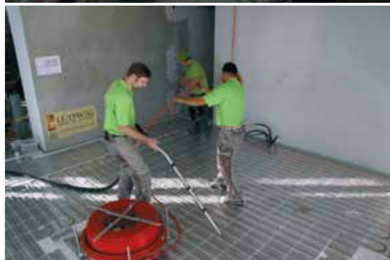
Die Rohrkanäle, deren konische Ausformung die Heizrohre fixieren, werden gesäubert, bevor die Rohre verlegt werden (links). Bevor der Bodenaufbau beginnt, wird eine Armierungsmatte verklebt (rechts)
